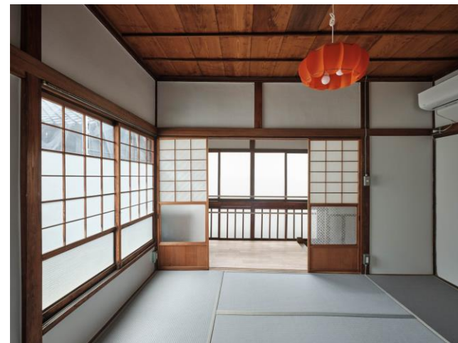
<(3)転落防止のための手すり付き窓>
