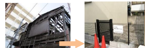
除却跡地を防災空地（墨田区）
