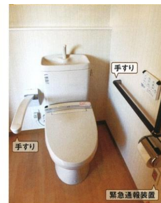
（建物内の様子）
