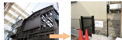
除却跡地を防災空地(墨田区)
