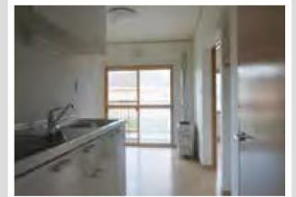
⑥防音サッシ設置(居間)
