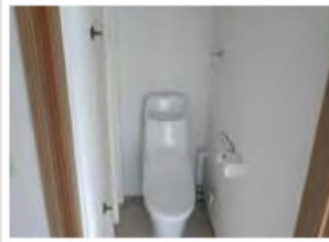
①手すり設置(トイレ)
