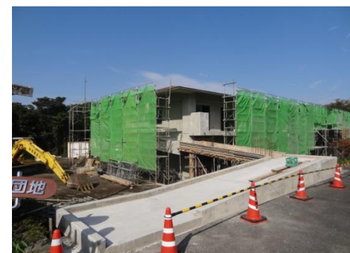
町営住宅（建設中）
