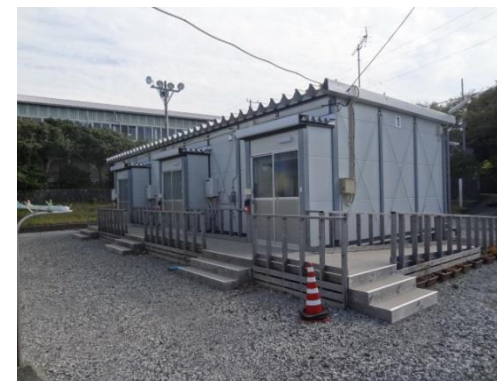
応急仮設住宅
