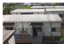
応急仮設住宅の建設
