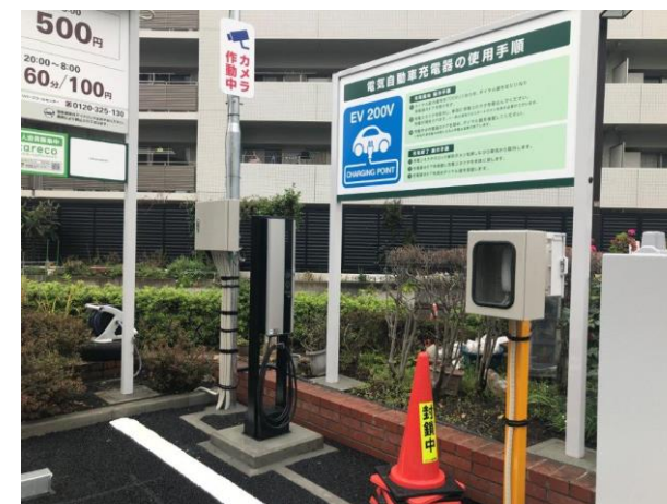
都営住宅における 電気自動車用充電器の設置の例
