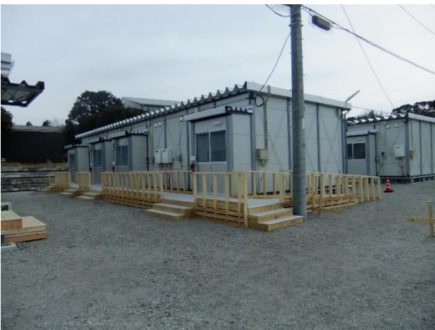
平成25年台風26号に伴う伊豆大島土砂災害時に建設した建設型応急住宅（実績46戸）
