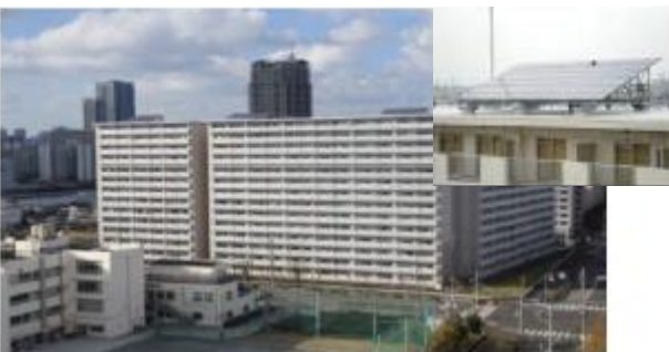
都営住宅への太陽光パネルの設置の例
