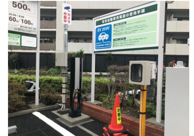
都営住宅における 電気自動車用充電器の設置の例
