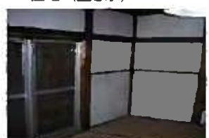
【改修前】 住宅（空き家）
