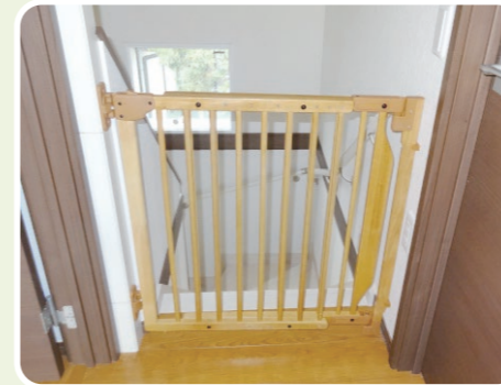
子供の転落防止対策
