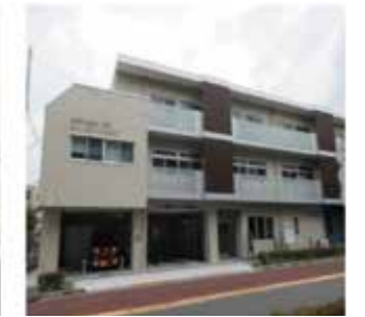
障害者支援施設（世田谷区）
