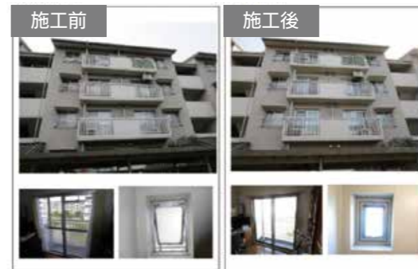
都市居住再生促進事業（既存ストック再生タイプ）省エネサッシ改修の例
