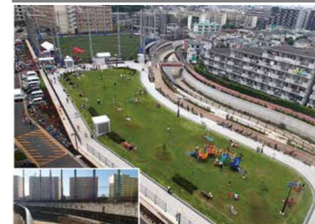
都営鷹の宮アパートの建替えに併せて整備された鷹宮調節池(妙正寺川)
