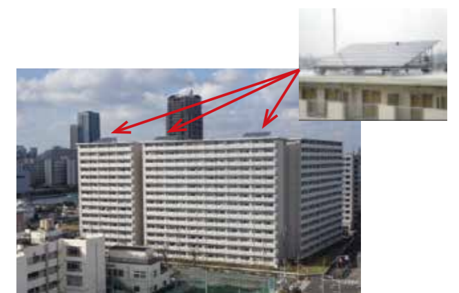
都営住宅への太陽光パネルの設置の例
