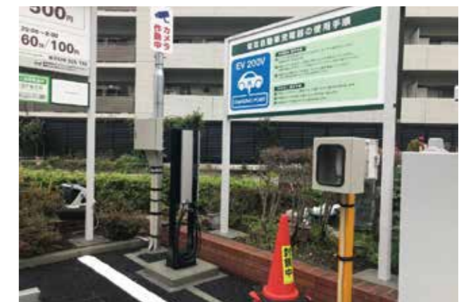
都営住宅における 電気自動車用充電器の設置の例
