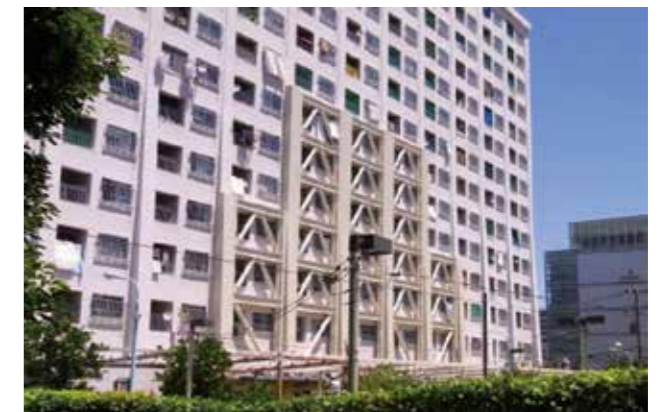
都営住宅の耐震化の例 (耐震ブレースによる補強)
