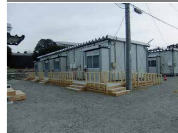
平成25年台風第26号に伴う伊豆大島土砂災害時に建設した建設型応急住宅（実績46戸）
