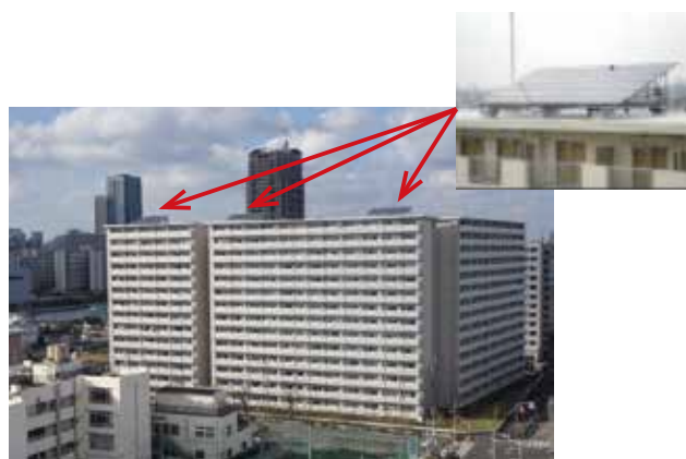
都営住宅への太陽光パネルの設置の例
