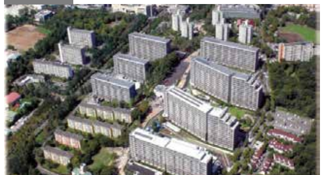
諏訪二丁目住宅（多摩市）
