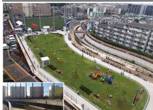
都営鷺の宮アパートの建替えに併せて整備された鷺宮調節池（妙正寺川）
