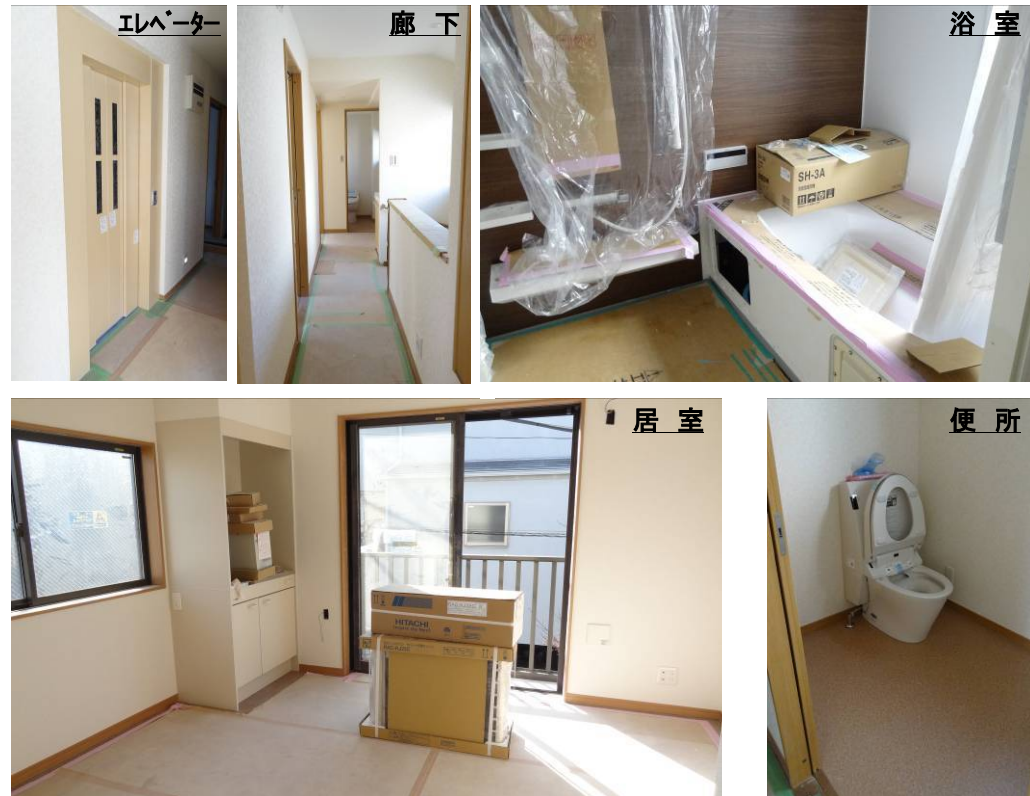
改修工事の様子
