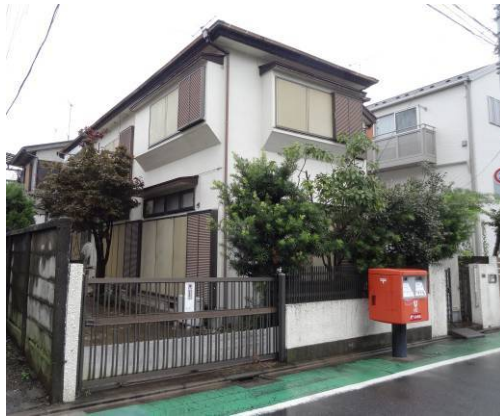
改修工事前(外観)
