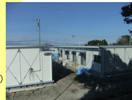
▲建設中の様子
