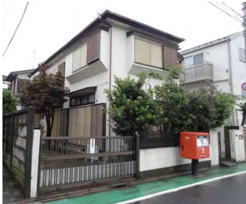
改修工事前(外観)
