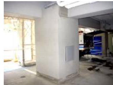
【柱増打ち、袖壁補強】
