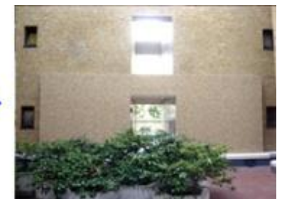
【耐震壁増打ち補強】
