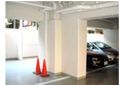
【柱増打ち、袖壁補強】
