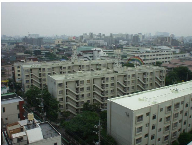
旧萩中住宅の一部外観写真
