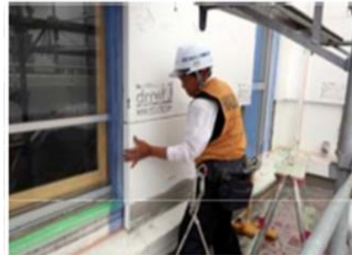
「エステート鶴巻4・5住宅」施工状況 壁の外断熱工事
