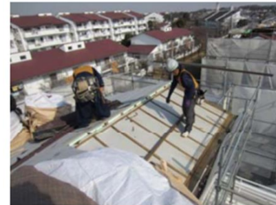
「エステート鶴巻4・5住宅」施工状況 屋根の外断熱工事
