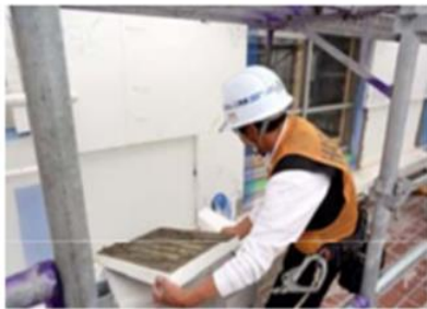
「エステート鶴巻4・5住宅」施工状況 壁の外断熱工事
