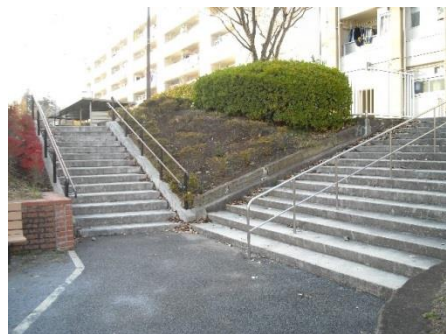
公園入口 ・地盤面の低い公園の入口は階段のみであることが多い
