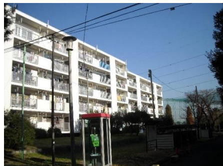
住棟 ・エレベーターは未設置 となっている
