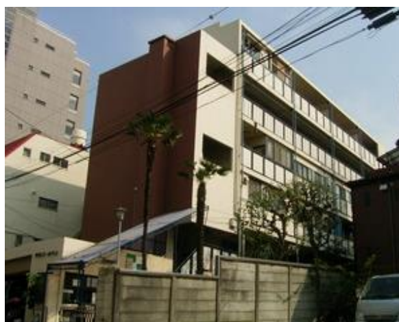
民間初の分譲マンション 「四谷コーポラス」 (昭和 31(1956)年)
