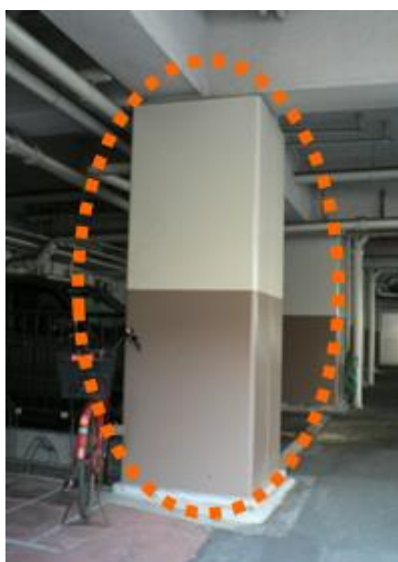
柱の補強（鋼管巻き補強） （昭和 45(1970)年築）
