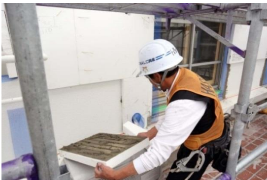
壁の外断熱工事
