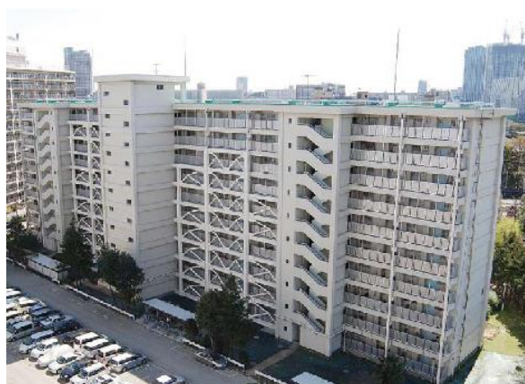
耐震改修されたマンション
