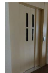
エレベーター
