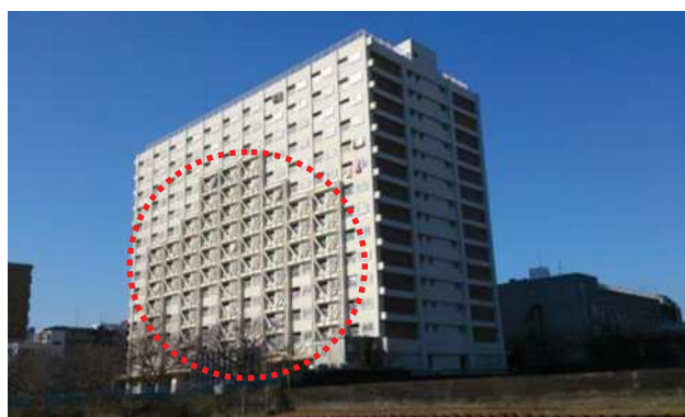
【耐震ブレースによる補強】
