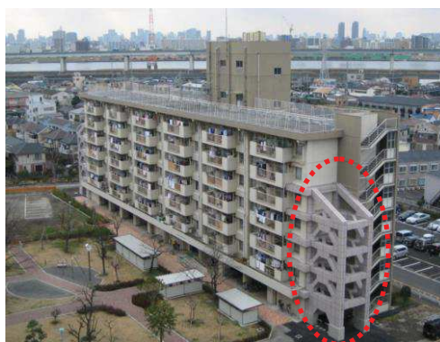
【建物妻面にバットレスを設置】
