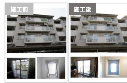
都市居住再生促進事業（既存ストック再生タイプ）省エネサッシ改修の例
