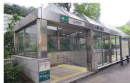
地下鉄出入口
