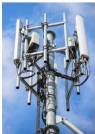
共有アンテナ設置
