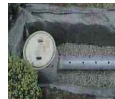
浸透トレンチ
