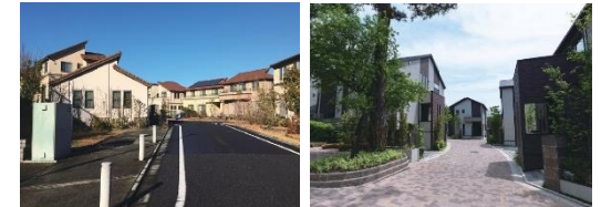
【宅地開発における無電柱化の事例】
