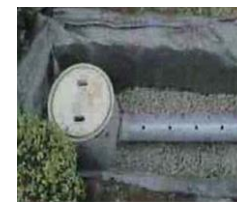
浸透トレンチ
