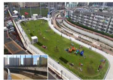
都営鷹の宮アパートの建替えに合わせて整備された鷺宮調節池（妙正寺川）
