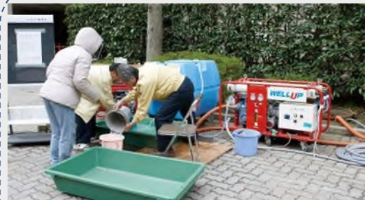
非常用飲料水生成装置の稼働風景
