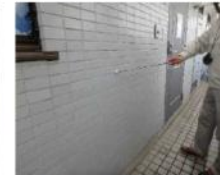
「外部（外壁）」調査の様子
