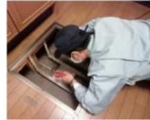
「土台・床組、基礎」調査の様子
