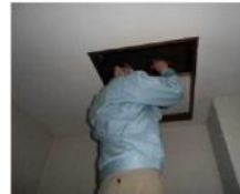
「小梁・梁」調査の様子
