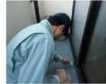
「外部（バルコニー）」調査の様子
