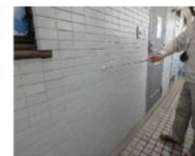
「外部（外壁）」調査の様子
