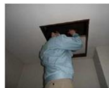
「小梁組・梁」調査の様子
