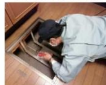
「土台・床組、基礎」調査の様子
