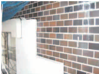
断熱材の張付け工事
