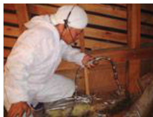
壁の内部に断熱材を注入
