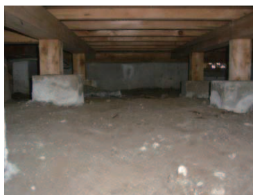
基礎の断熱改修(施工前)
