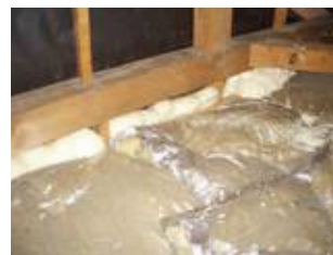
断熱材注入後
