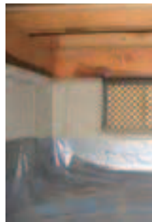
防湿シートの敷き込み
